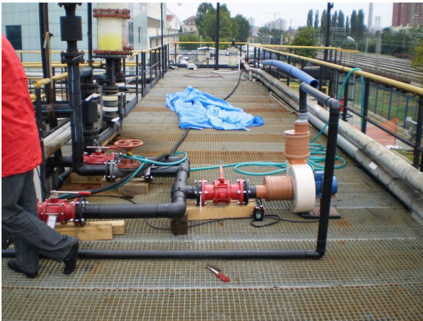
Slika 4. Ventilator spojen na kolonu za ispiranje plinova.
