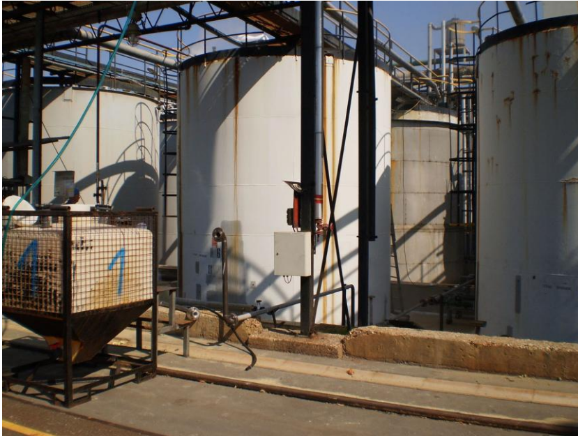
Slika 1. Spremnici s klorsulfonskom kiselinom.
